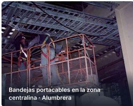
Bandejas y caños de HºGº en la centralina · Alumbraera
