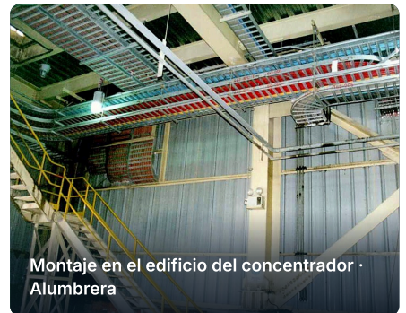
Bandejas y caños de HºGº en la centralina · Alumbraera
