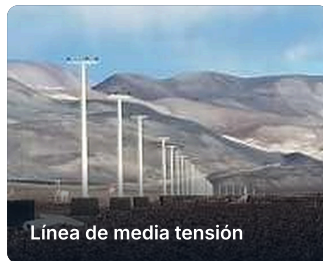
Postación de hormigón
